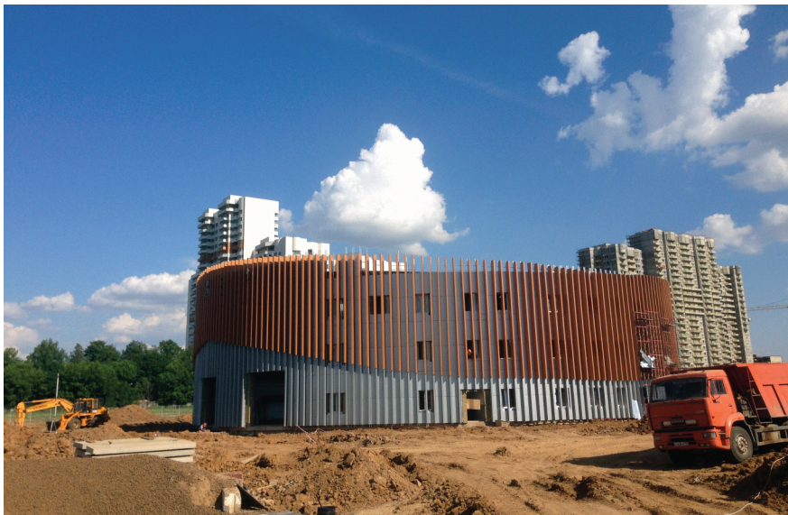
Рис. 6. Комплексный блок очистной станции канализации закрытого типа в бетонном исполнении. Строительство «под ключ» ЗАО «Компания «ЭКОС»» в инновационном центре «Сколково»
