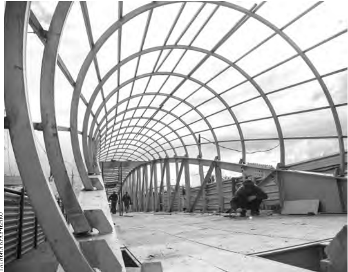
Основная часть конструкции пешеходного моста уже собрана.
