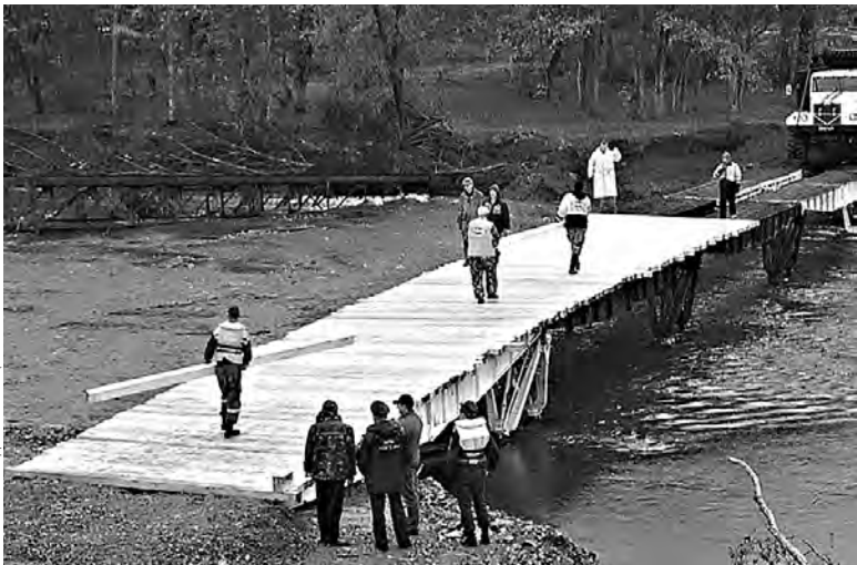
Механизированный мост через реку Зеркальную спасатели составили из четырех пролетов.
