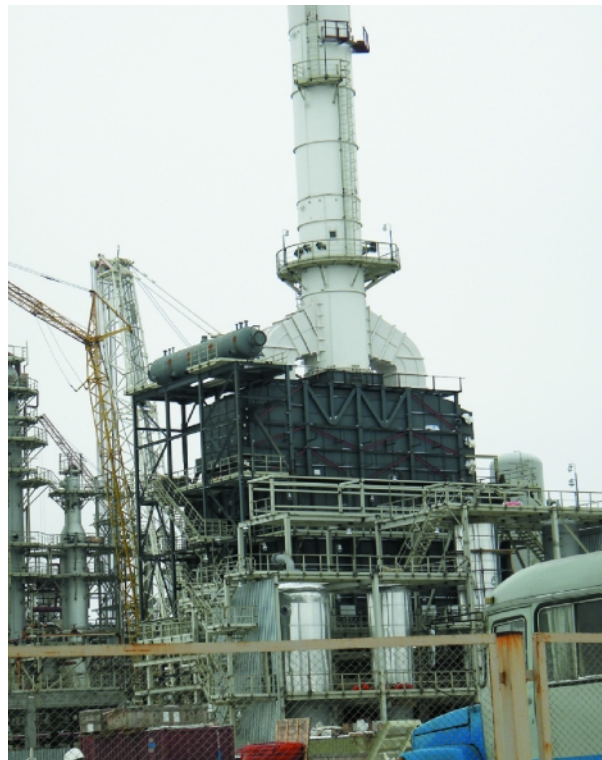
Монтаж парового барабана весом 35 т
