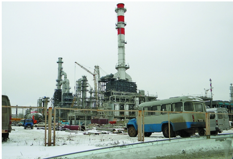
Монтаж дымовой трубы весом 98 т
