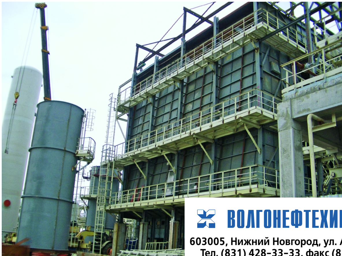
Монтаж парового барабана весом 35 т
