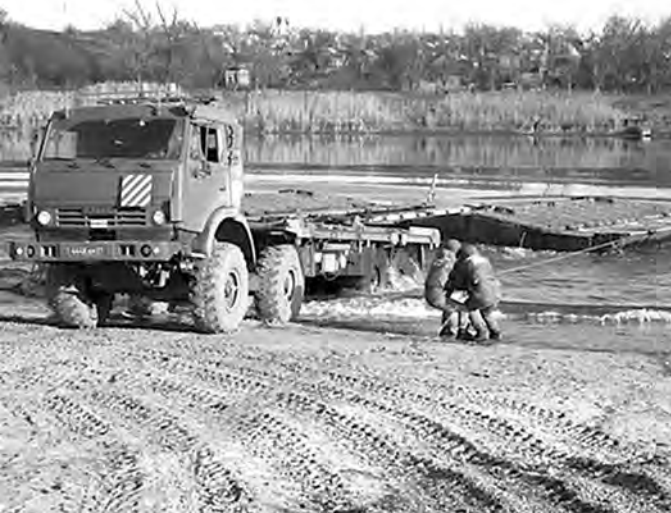
Переправа, длина которой 60 метров, состоит из девяти звеньев. В ее возведении задействовано более 50 человек.
