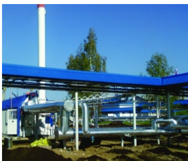
Реконструкция тепловых сетей НПС «Приводино» (Архангельская обл.). Монтаж тепловых сетей и блочной котельной
