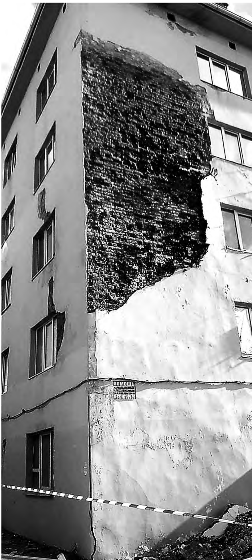
На глазах у прохожих с фасада отремонтированного дома сползло 20 квадратных метров облицовки.
