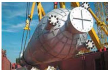
«Роснефть» провела уникальную транспортную операцию по доставке реакторов установки гидрокрекинга.
