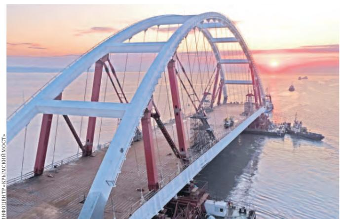
Вчера началась морская операция по транспортировке и установке автодорожной части Крымского моста длиной 227 метров. Утром арку с помощью системы плавсредств вывели в фарватер Керченского пролива. В створ между опорами ее притянули мощными якорями. Самая ответственная часть операции — подъем конструкции весом 5500 тонн на проектную высоту.
