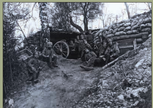
Артиллерийский блиндаж для скрытой установки 9-дюймового орудия образца 1910 г. Польша, весна 1915 г. ГА РФ
