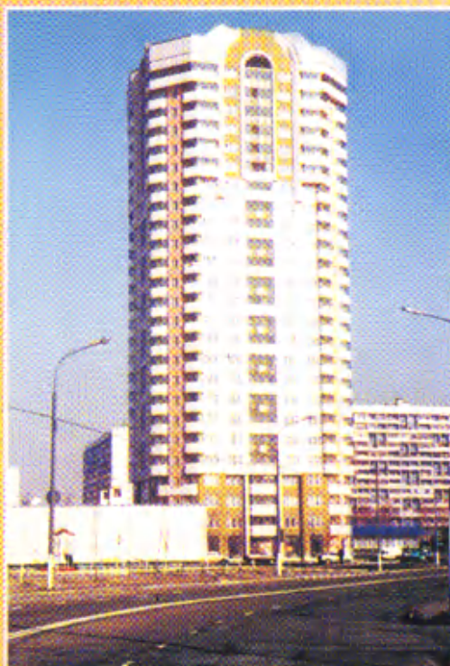
Построенное в алюминиевой опалубке здание на Братеевской улице. Строительная фирма «Главмонолитстрой»
