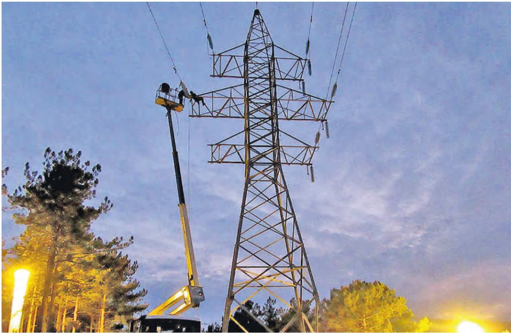
Энергетики восстановили поврежденную на прошлой неделе высоковольтную опору линии электропередачи в Алуште, от которой запитаны часть населенных пунктов ЮБК. Сотрудники «Крымэнерго» полностью заменили поврежденные несущие конструкции и элементы опоры, а затем установили ее с помощью подъемного крана. Для ремонтных работ энергетикам пришлось прокладывать временную дорогу в горно-лесной местности. Напомним, по факту диверсий на ЛЭП и газопроводах УФСБ по РК возбудило три уголовных дела.
