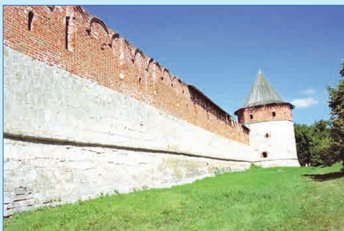
Зарайский кремль, Казённая башня. Белокаменная ▲ облицовка доходит более чем до половины высоты стен этой крепости
