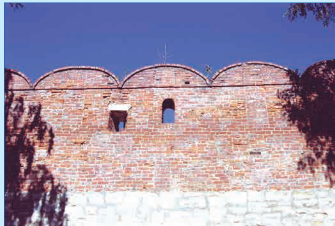
▲ Промежутки между зубцами в форме ласточкиного хвоста при позднейших перестройках
